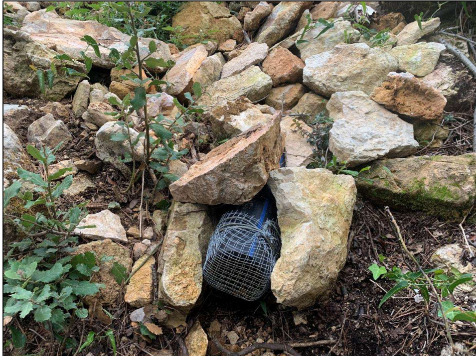
Figure 5 : Exutoire de la purge du forage
